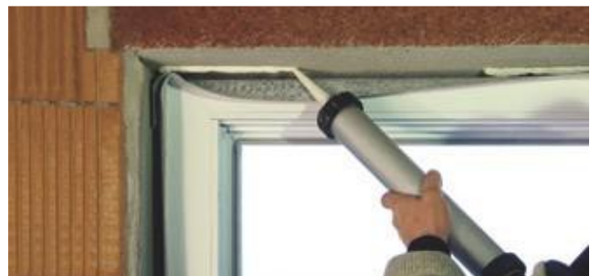
Ejemplo de aplicación: ISO-TOP FLEX-ADHESIVE SP
