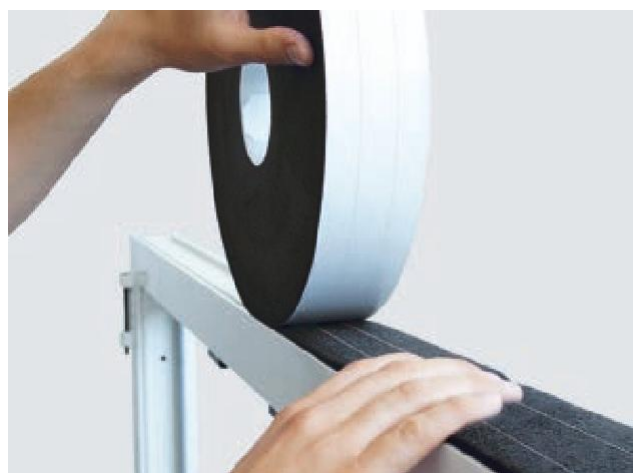
Ejemplo de instalación: ISO-BLOCO HYBRATEC
