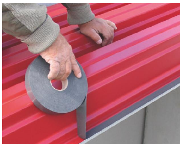
Ejemplo de instalación: ISO-ZELL FIXTAPE
